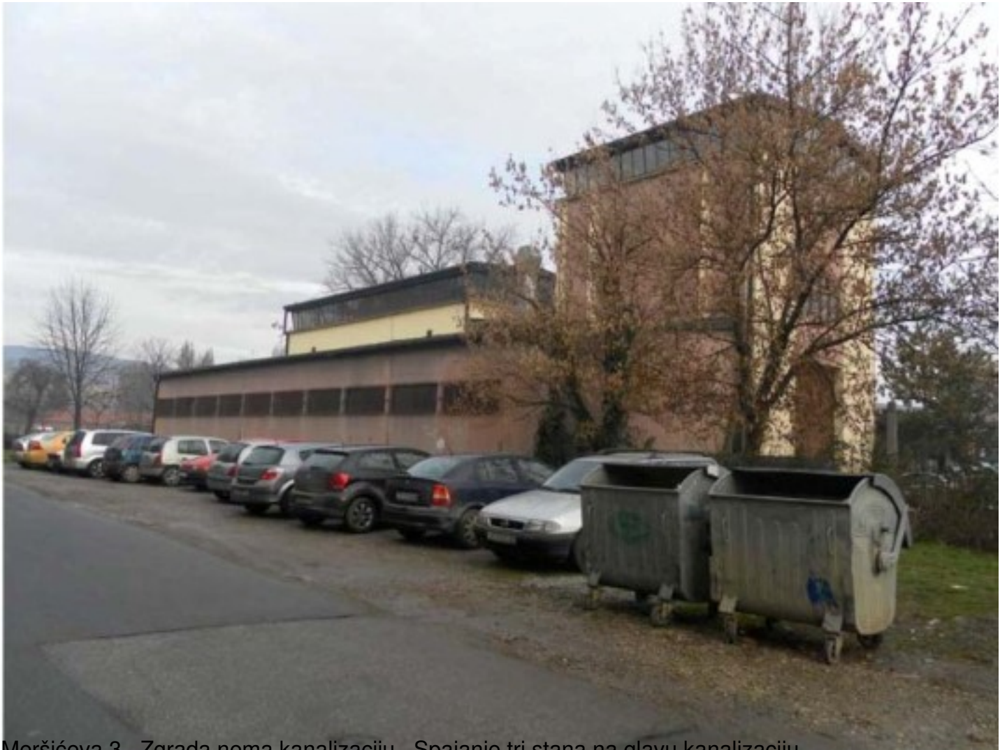
Meršičeva 3. Zgrada nema kanalizaciju. Spajanje tri stana na glavu kanalizaciju.
