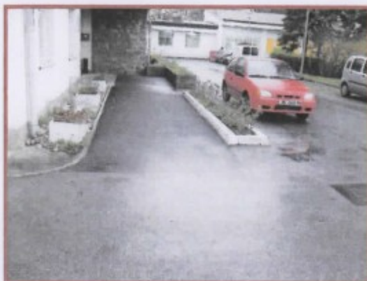
Asfaltiran ulaz i postavljeni rubnici između ceste i prolaza.
